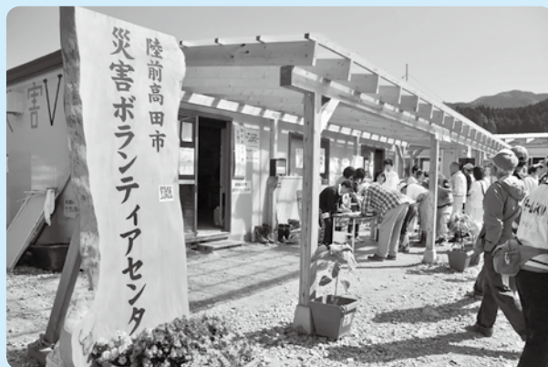
平成 23 年 陸前高田市の災害ボランティアセンターの様子
