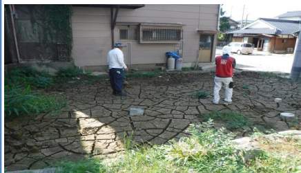
【現地調査の様子】
